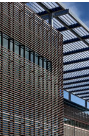
Terra cotta brise soleil.
